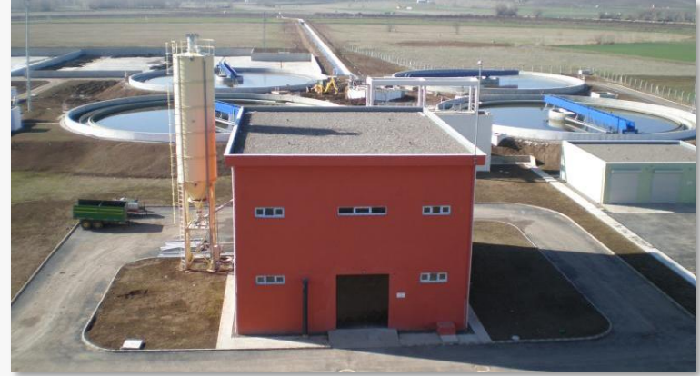
Atıksu Arıtma Tesisi (Sivas)
