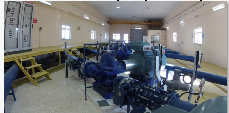
Sivas İçmesuyu Terfi İstasyonu
