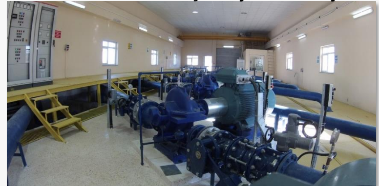
Sivas İçmesuyu Terfi İstasyonu
