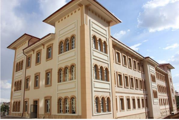
Zara Hükümet Konağı
