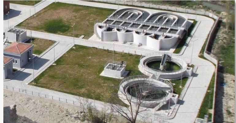
Atıksu Arıtma Tesisi (Gürün)
